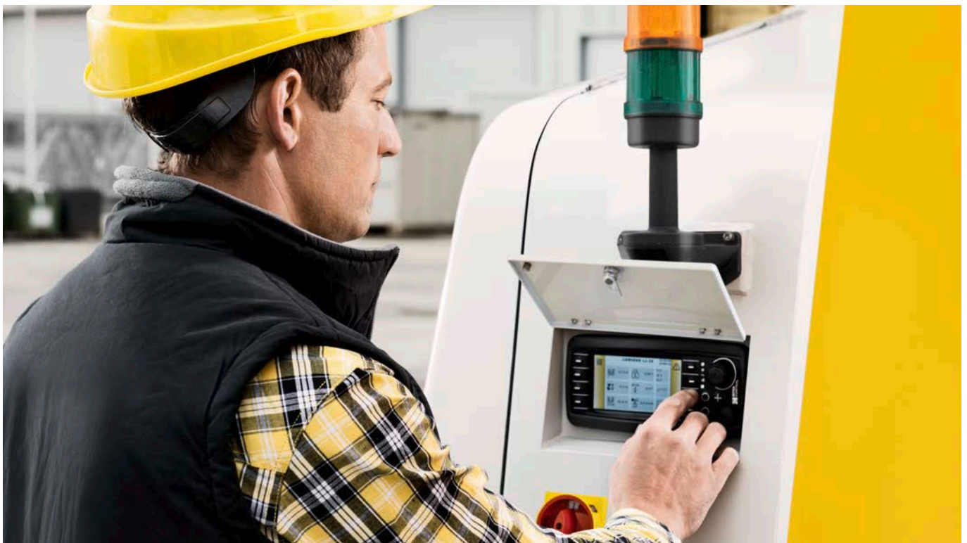
Einstellungssache: Einfache Bedienung am gut zugänglichen Schaltschrank
